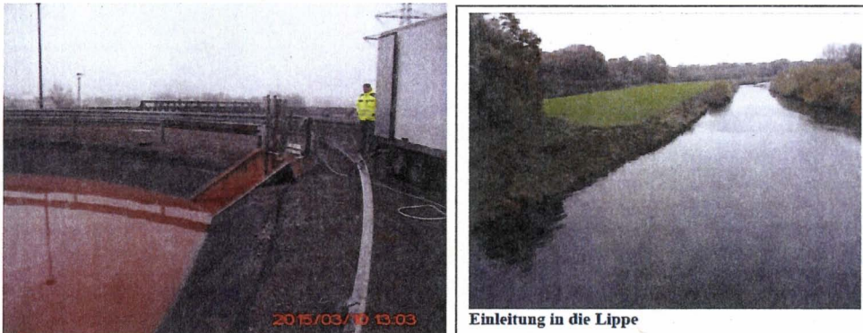
Abbildung 26: Grubenwassermessstelle mit Zentrifugenprobenahme und Einleitung Zeche Auguste Victoria, Fotos LANUV und RAG (Einleitung)
