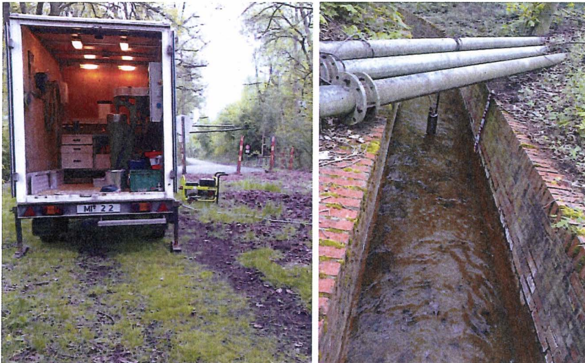
Abbildung 30: Grubenwassermessstelle und Einleitung aus dem Dickenberger Stollen, Foto LANUV
