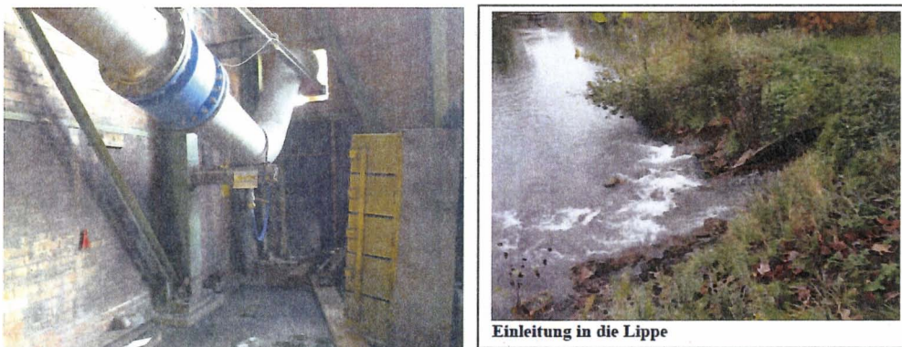
Abbildung 24: Grubenwassermessstellen und Zentrifugenprobe und Einleitung Zeche Haus Aden, Fotos LANUV und RAG (Einleitung)
