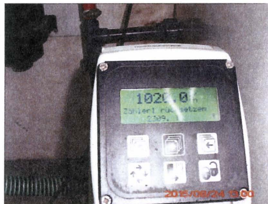
Abbildung 3: Mess- und Regeleinheit für den Zentrifugendurchfluss
